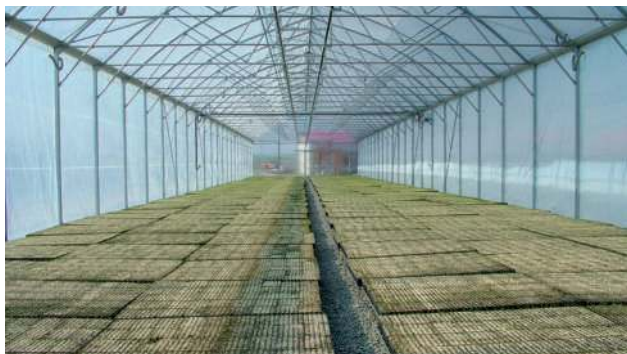
Obr. 2.90 Velkoobjemový fóliovníkový halový kryt zaplněný osetými sadbovači uloženými na speciálních kovových roštích. Firma Lescus Cetkovice, s. r. o. (Foto autor)
