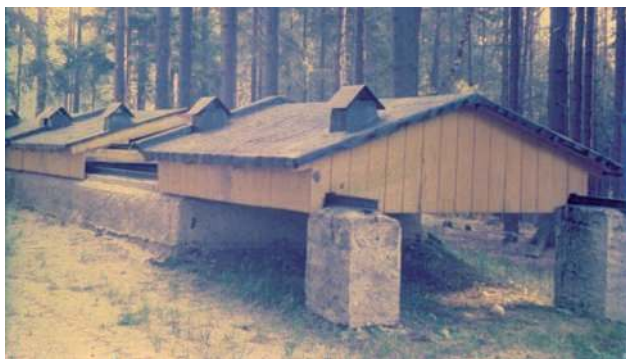
Obr. 1.37 Ve větších školkách se začaly podle unifikovaného projektu budovat sněžné jámy s posuvnou střechou umožňující lepší přístup do prostoru jámy zejména při navážení sněhu. (Archiv autora)
