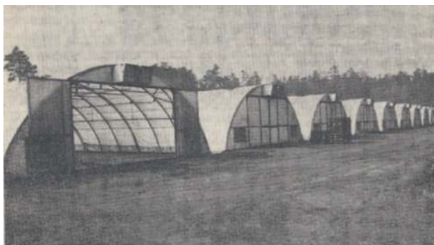
Obr. 1.54 Velkoškola Zelená Bouda – řada fóliovníků typu Olbramovice k pěstování semenáčků lesních dřevin – rok 1969. (Archiv autora)
