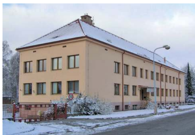
Obr. 6.01 Budova Výzkumné stanice v Opočně. Výzkumný ústav lesního hospodářství a myslivosti, v. v. i. (Foto Jarmila Martincová)
