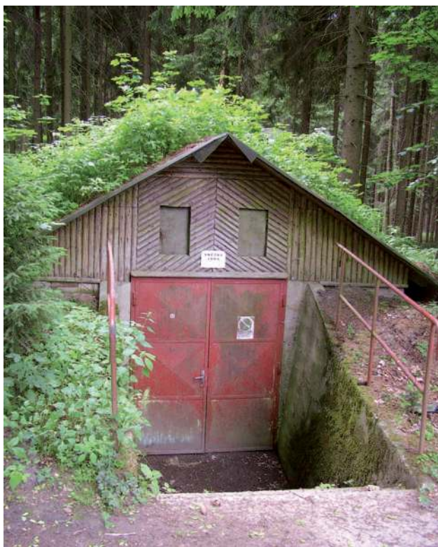
Obr. 1.38 Ukázka sněžné jámy k uložení sazenic, budované podle unifikovaného projektu jako stabilní trvalá stavba v lesích. (Foto autor)
