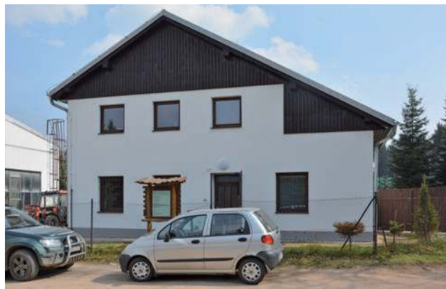
Obr. 2.05 Lesy města Brna, a. s., centrální budova střediska Lesních školek Svinošice. (Foto autor)
