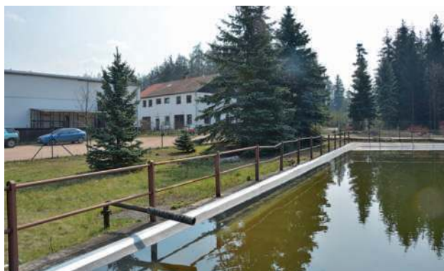
Obr. 2.07 Bazén na přehřívání závlahové vody čerpané z vrтанých studní. Lesní školky Svinošice. (Foto autor)
