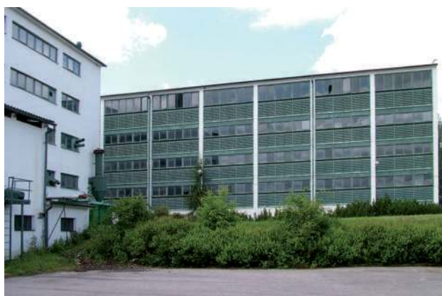
Obr. 4.04 Ná vazná provozní budova Semenářského závodu v Týništi nad Orlicí, kde probíhá skladování semenné suroviny – stav v roce 2014. (Foto autor)
